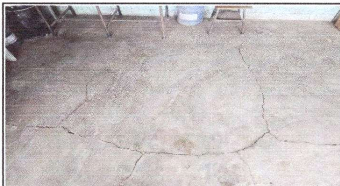
Foto 3: Sustitución de piso cerámico
