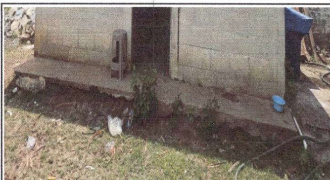
Foto 4: Reparacion de banqueta
