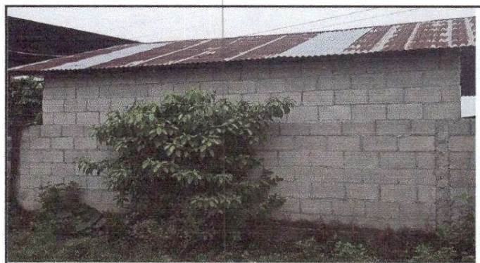
Foto 10: Sellado de grietas y fisuras
