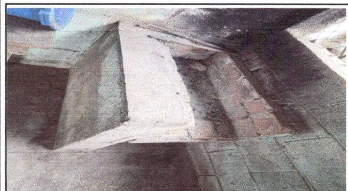
Foto 9: Sustrucción de estufa rural completa
