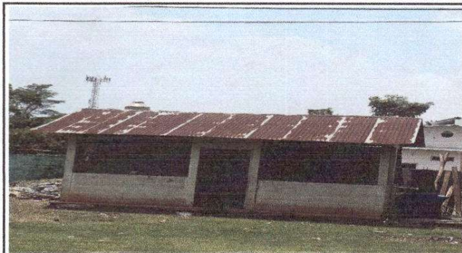
Foto1: Sustitución de lámina
