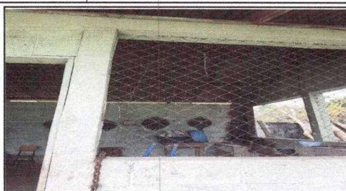
Foto 8: Sustrucción de estructura de metal de ventana
