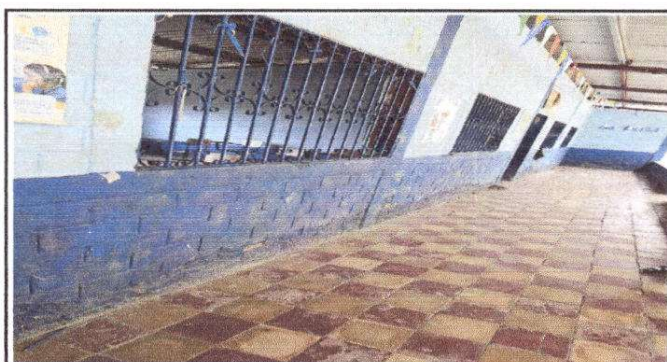
Foto 5: Pintura en muros exteriores e interiores
