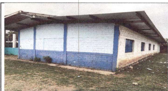
Foto 6: Repello en muro
